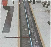
3 遊間部・バックロッド挿入
