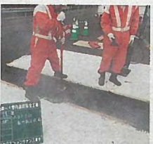
7 タンパによる締固め
