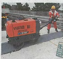
9 ローラー(仕上げ)
