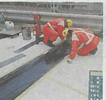
4 プライマー塗布
