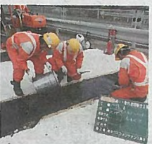
8 プライマー塗布(仕上げ)
