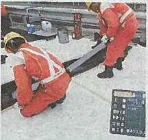
5 ギャッププレート設置
